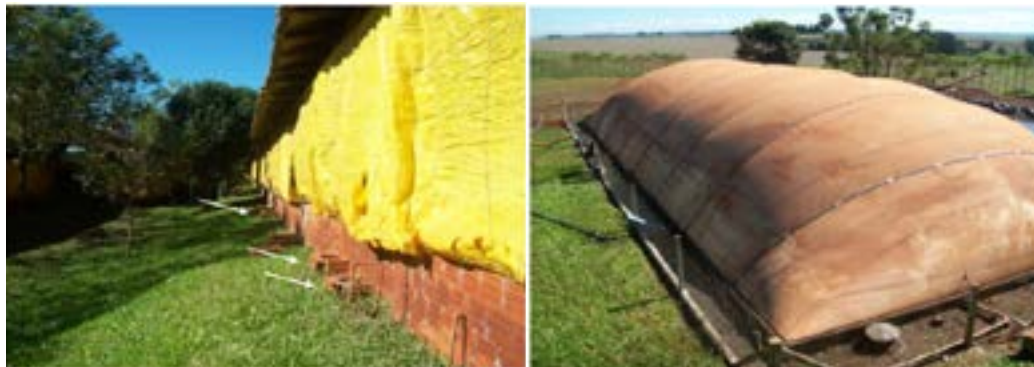
Figura 2 – Tubulação coletora de dejetos e biodigestor modelo canadense.
