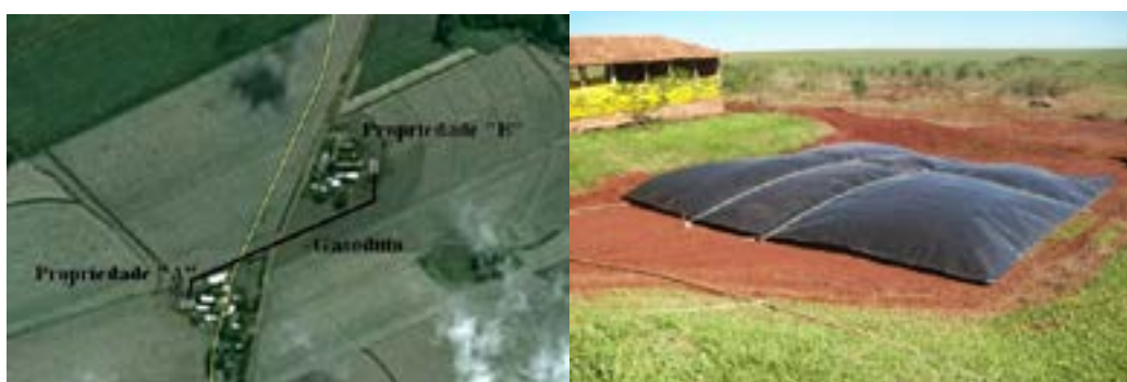
Figura 03: Visualização do Gasoduto e balão de armazenamento
